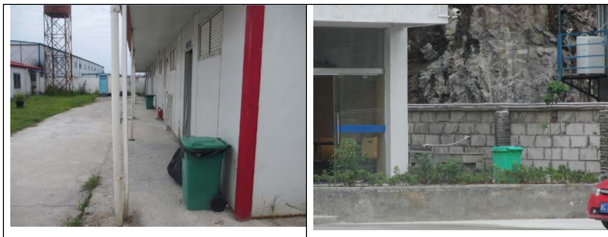
图 4.1-7 施工营地生活垃圾收集装置
