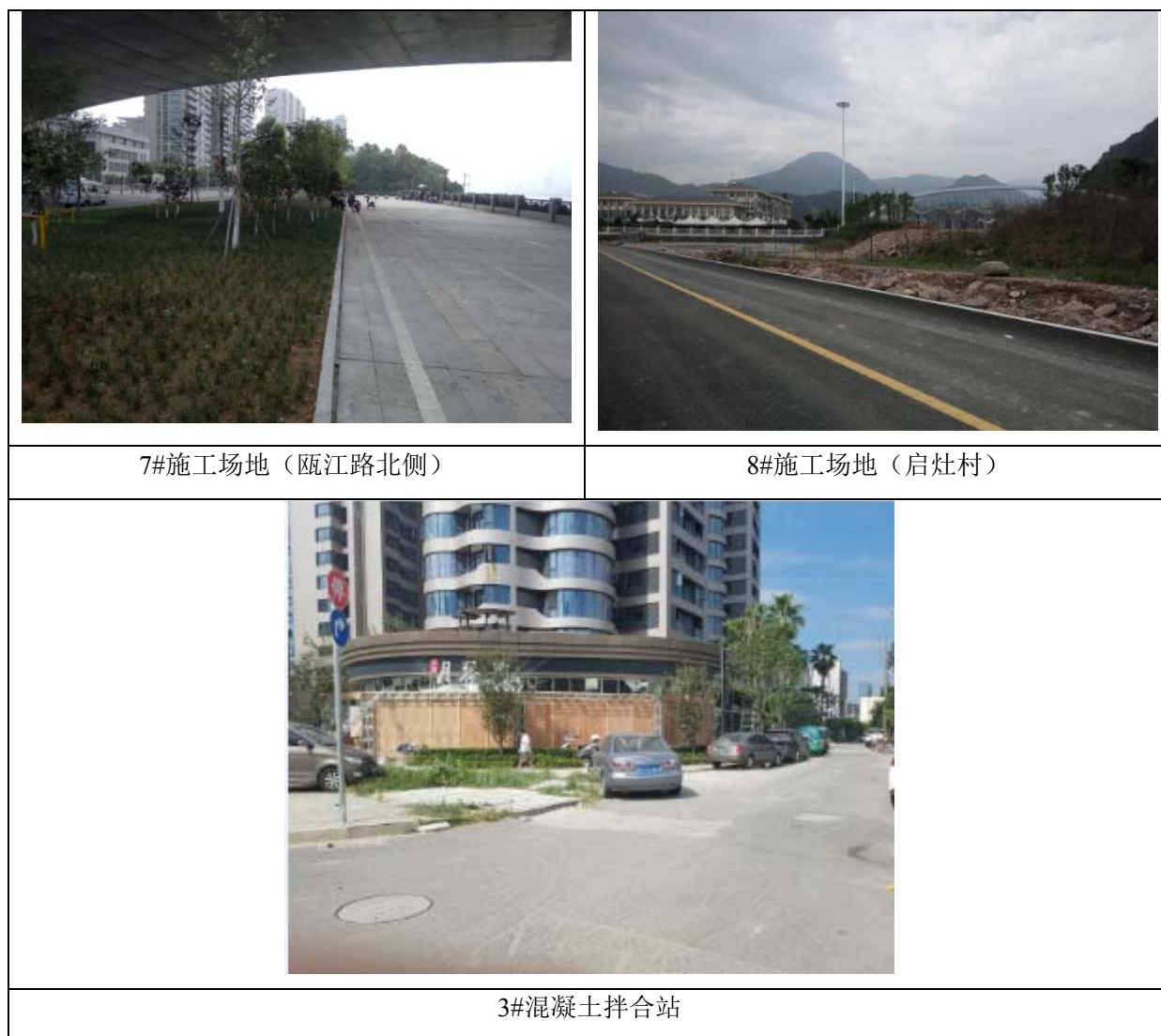
图 4.2-3 施工场地现状图
