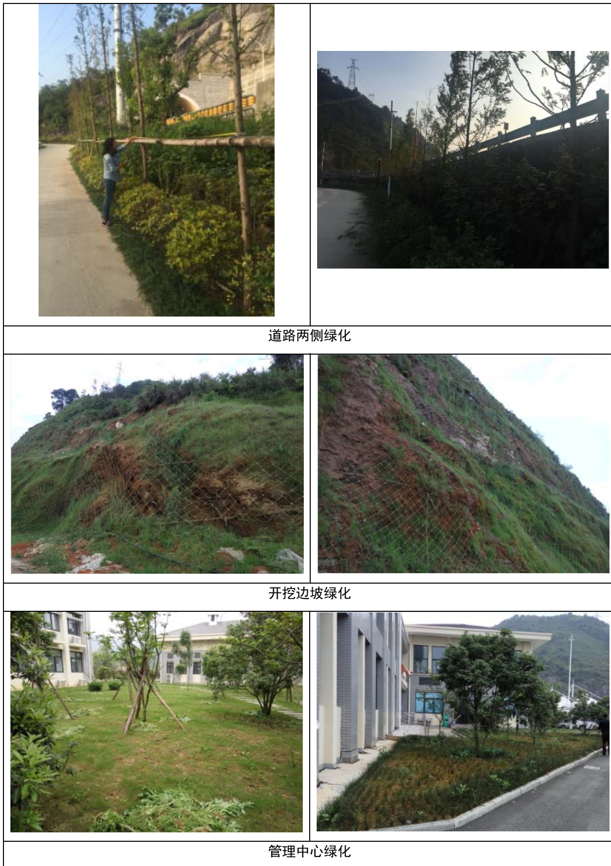
图 4.2-1 互通立交区、中央分隔带、桥下、道路两侧、开挖边坡、管理中心景观绿化现状图
