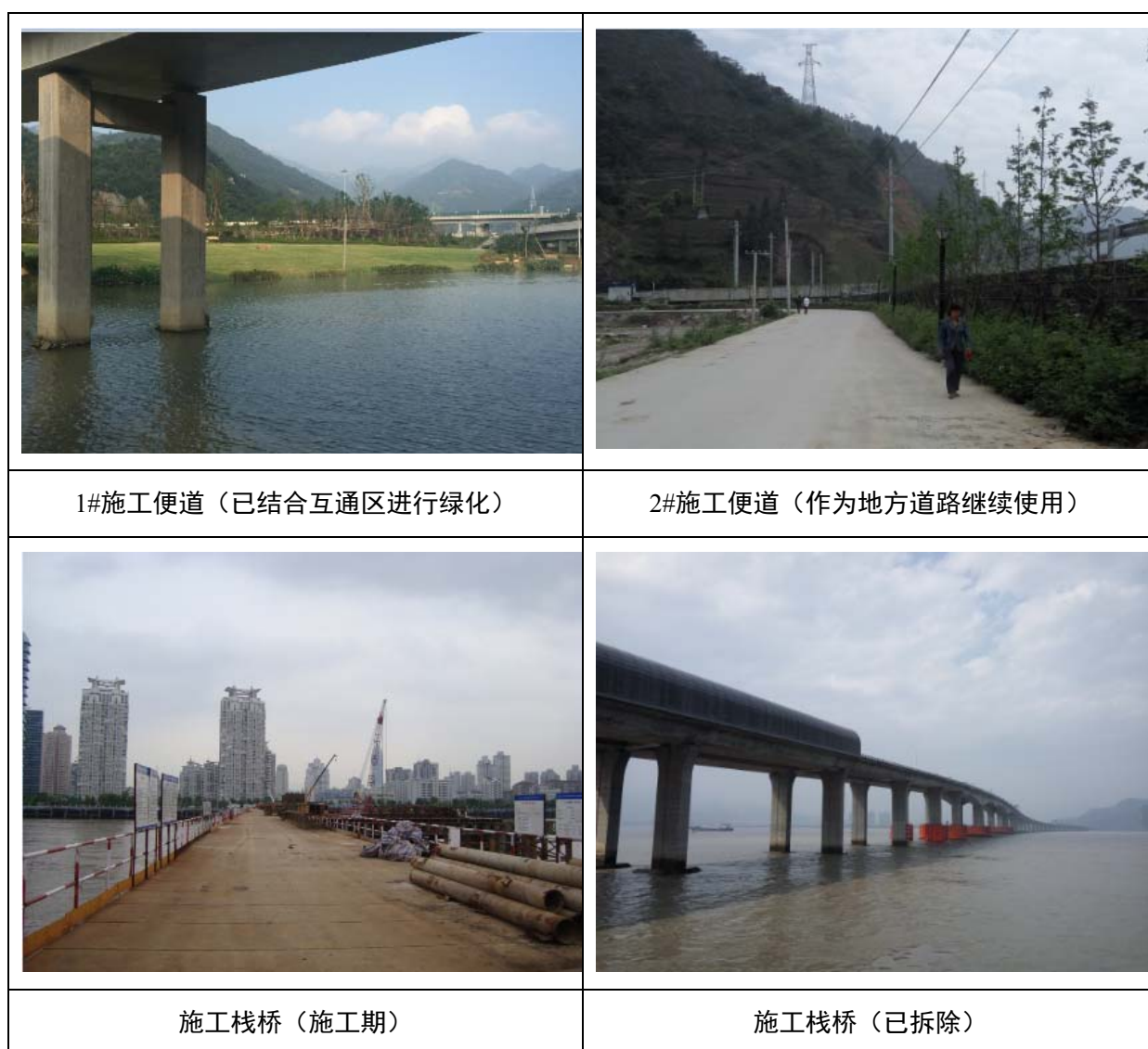
图 4.2-4 施工便道、栈桥现状图
