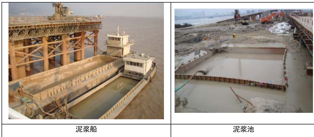
图 4.1-2 桥梁施工废水处理措施
