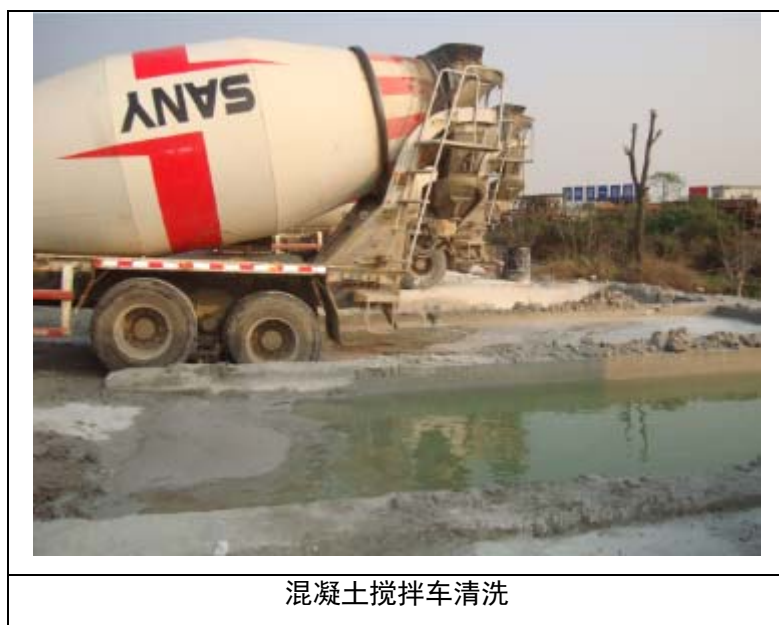
图 4.1-3 施工车辆清洗、沉淀设施
