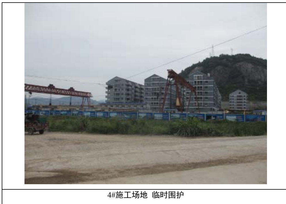
图 4.1-6 施工期噪声防护措施
