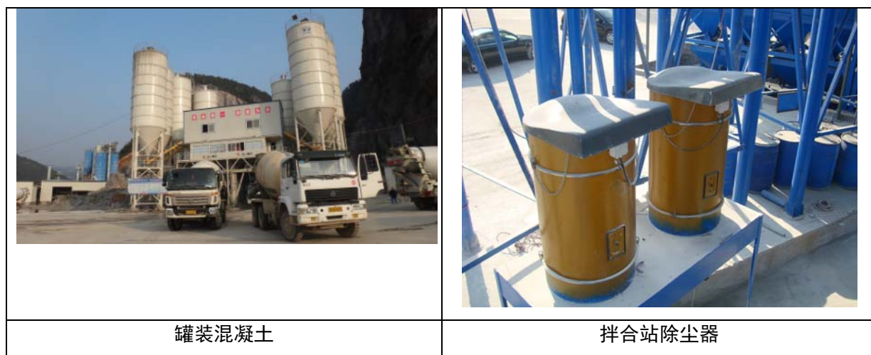
图 4.1-5 施工期大气环境保护措施
