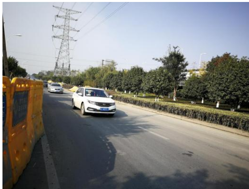
图 1-4 瓯海大道南侧辅道路改桥段现状
