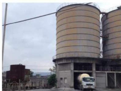
项目西南侧万年青散装水泥
