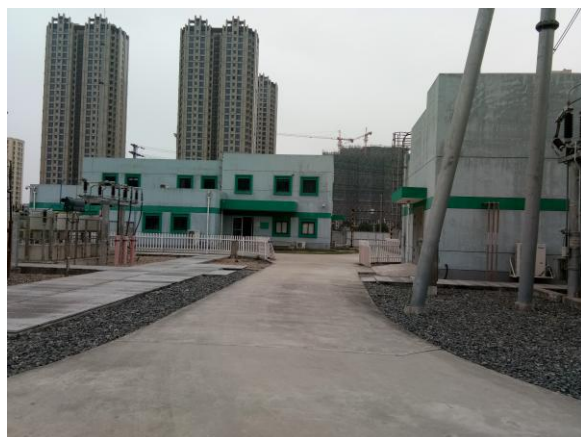
图 6-8 站内道路及碎石硬化
