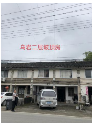
图 3-6 乌岩二层坡顶房
