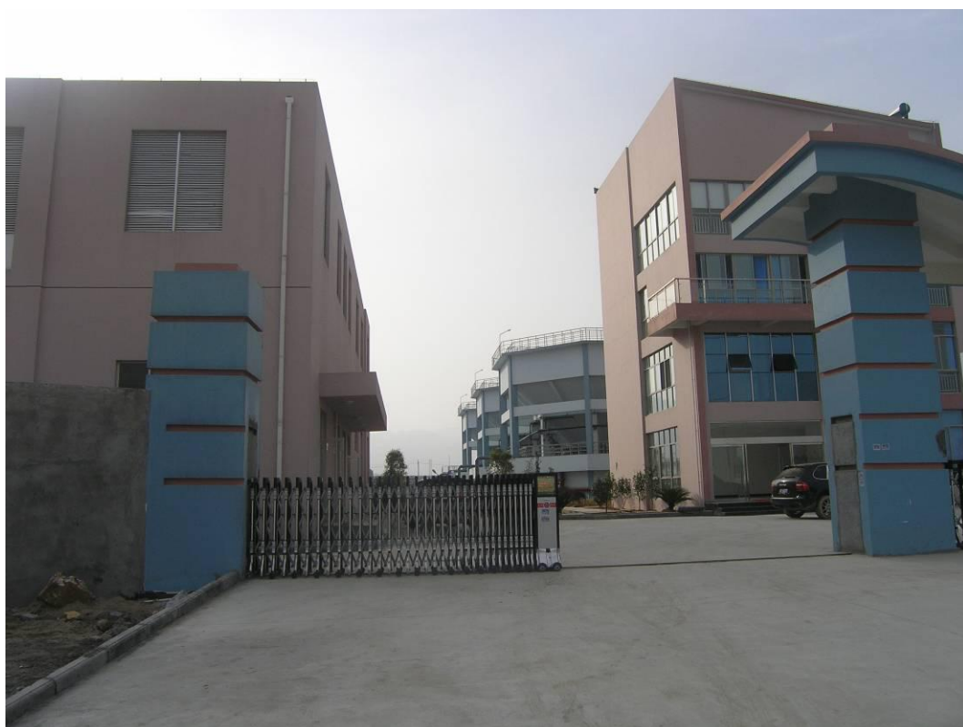
图 4.3-1 滨海园区第二污水处理厂照片
