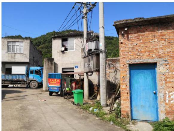
图 3-2 (20) 沿山路 38 号民房及厂房
