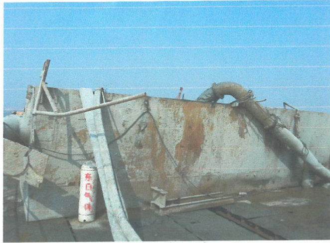
泥浆池循环沉淀
