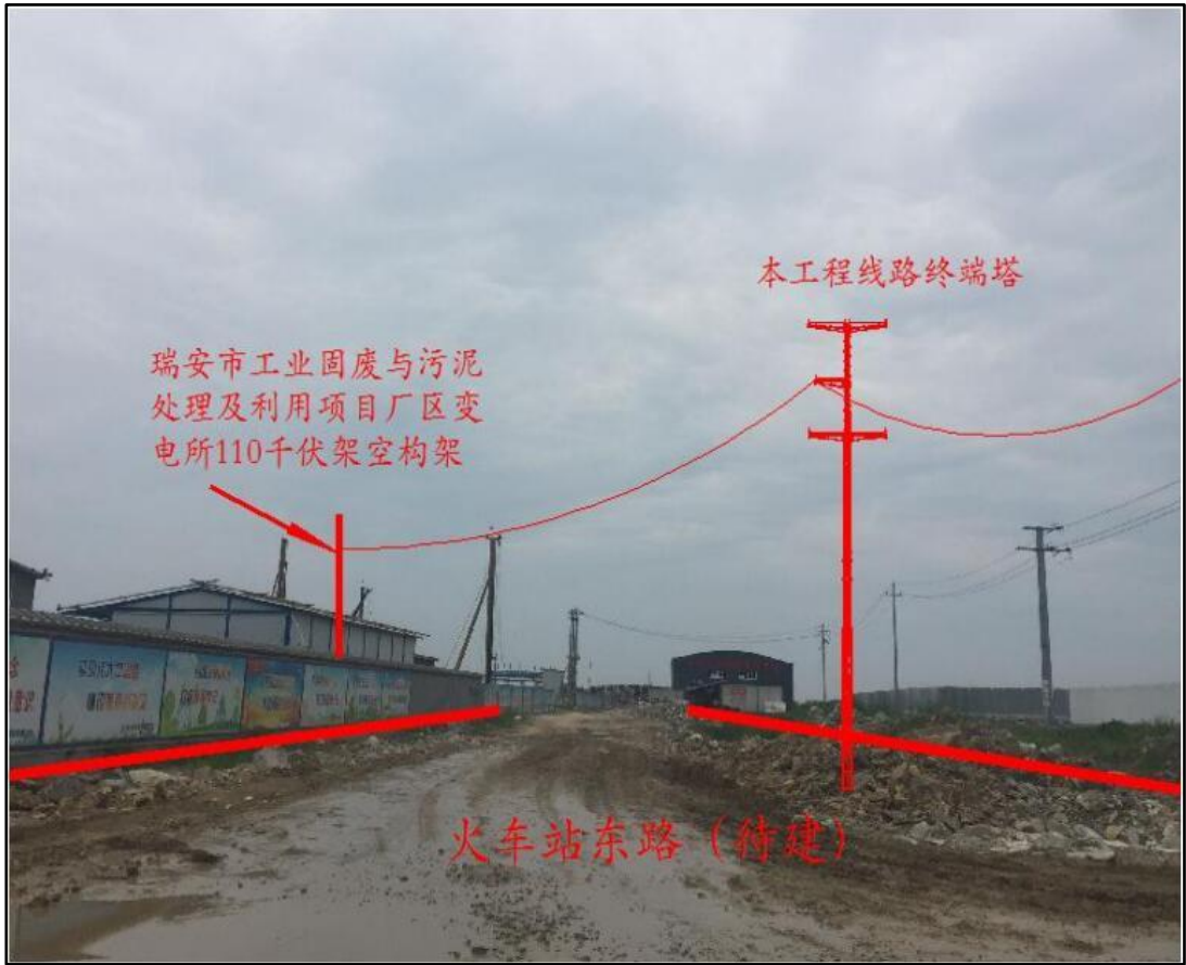
图 1.4 大有热电厂区出线示意图
