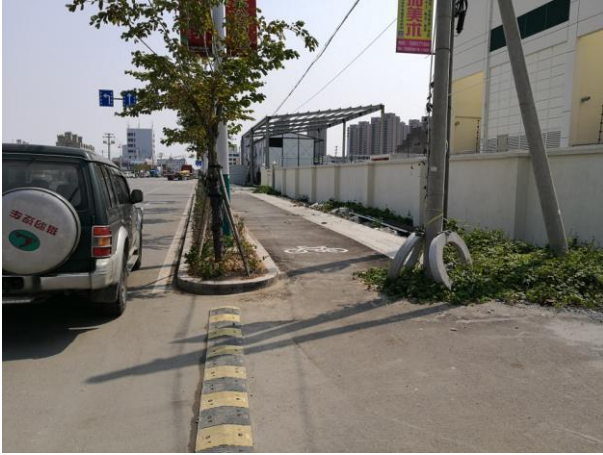
图 6-7 变电站北侧外环境
