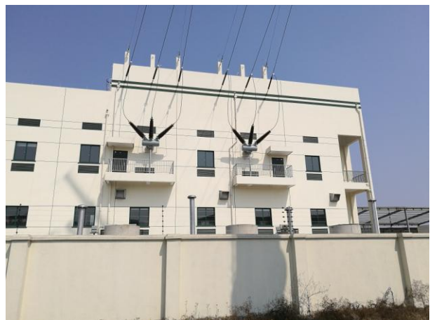
图 6-6 110kV 出线
