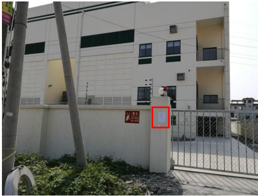
图 10-1 变电站门口公示
