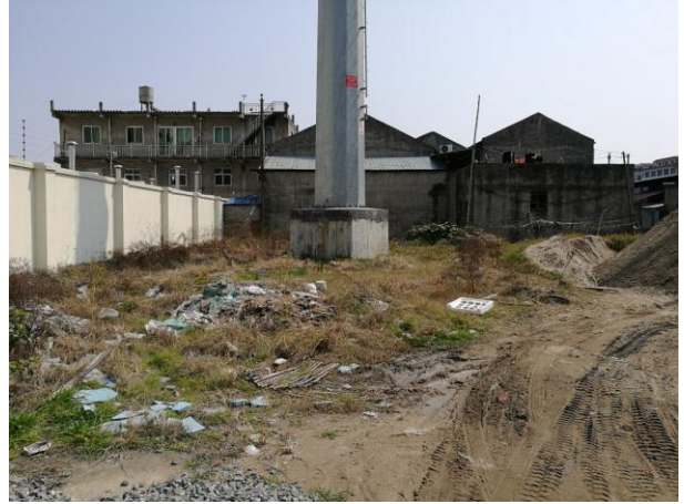
图 6-8 变电站南侧外环境
