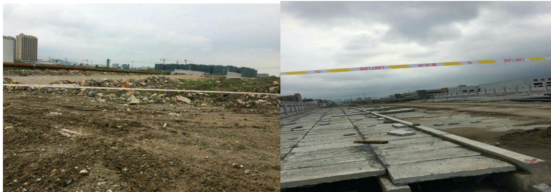
图 6-8 现场作业照片
