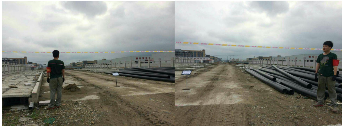
图 6-7 现场作业照片
