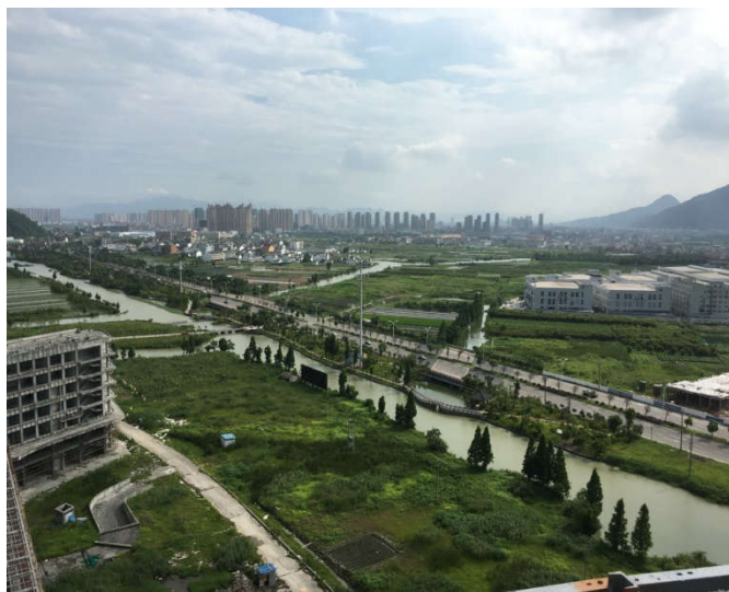
(c) 项目西侧-昆鳌大道
