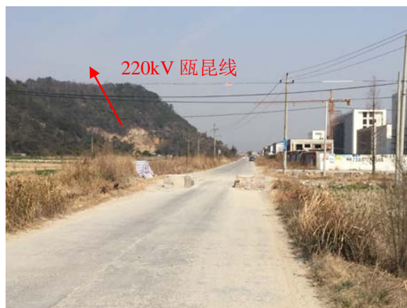
220kV 瓯昆线改造工程
