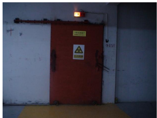
图 6-4 警示标识、信号灯、声光报警装置
