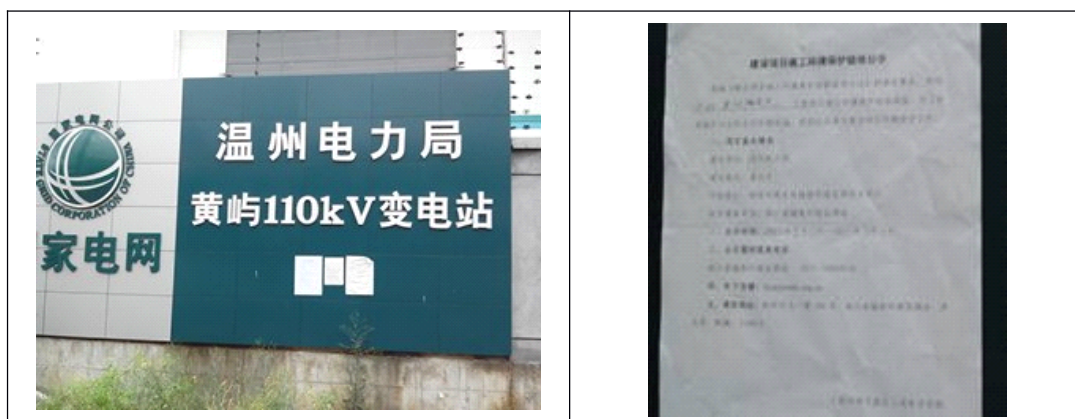
图 10-1 110kV 黄屿变电站门口公示
