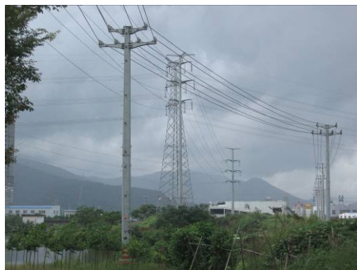
图 8-6 塔杆跨越河流
