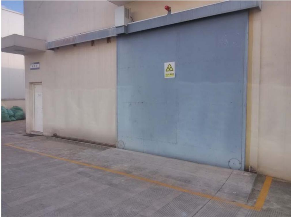
图 6-5 工件防护门外设置的警戒线
